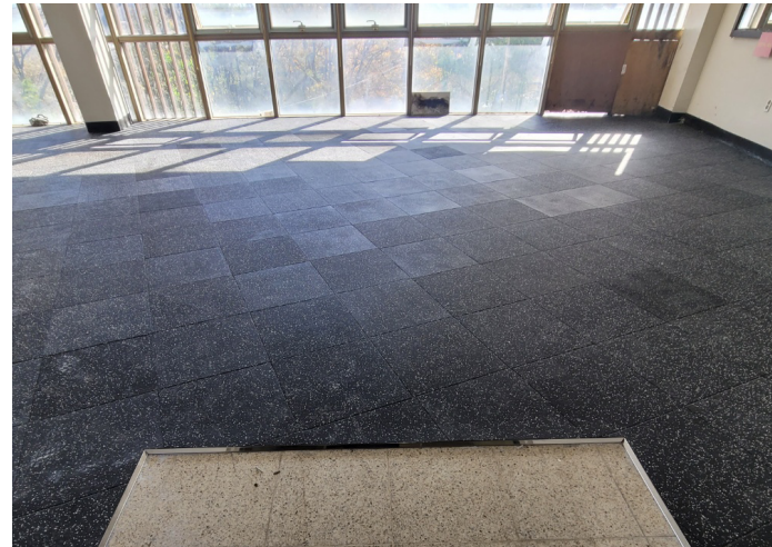
<해병 2사단> 시공 후
